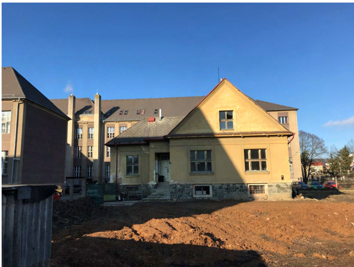
Obr. 2 - Snímek stávajícího objektu v řešené části – pohled od říčky Litavka
