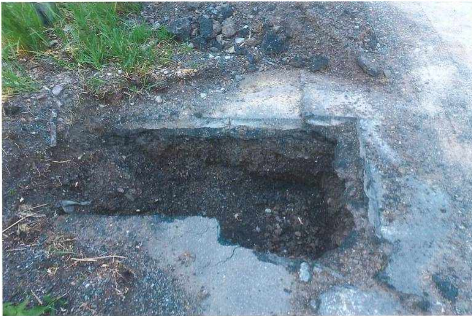
Sonda - stávající konstrukce vozovky
