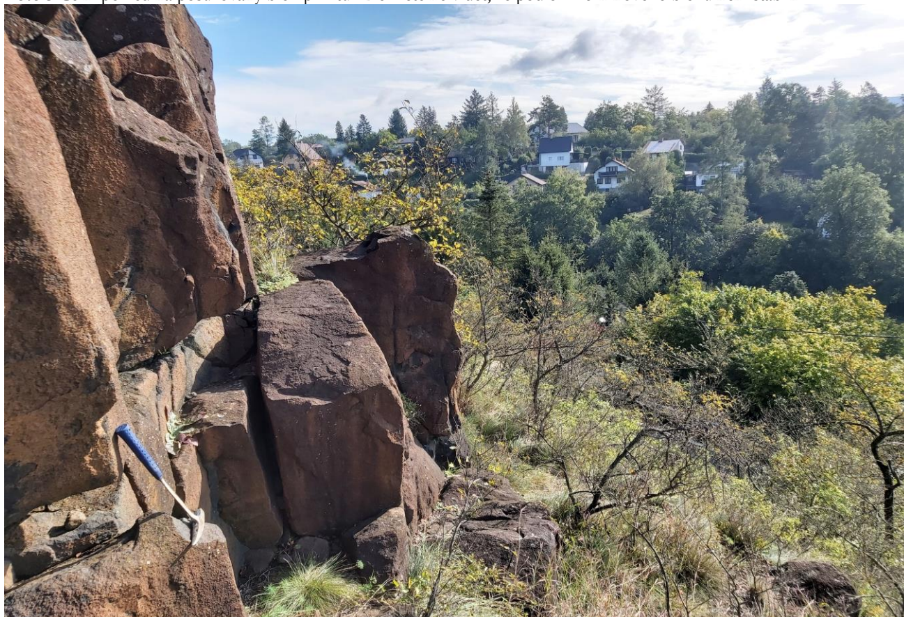
Foto 4 Rozsáhlý skalní výchoz nad silnicí II/116. Skalní masiv je postížen výrazným puklinovým systémem směru SV-JZ.
