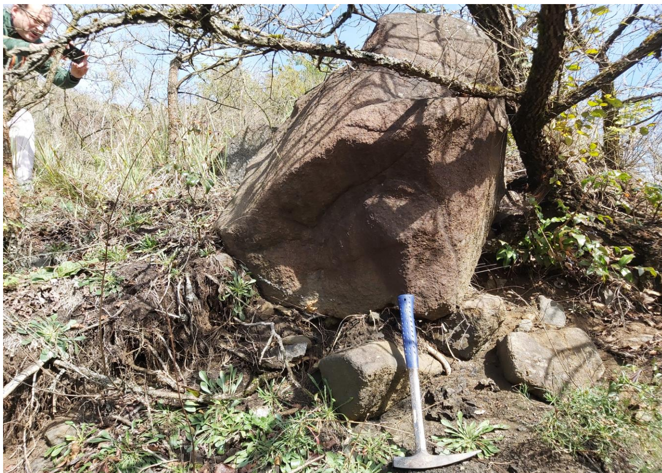
Foto 3 Čelní pohled na posuzovaný blok pikritu. Lze zřetelně vidět, že podloží horninového bloku není stabilní.
