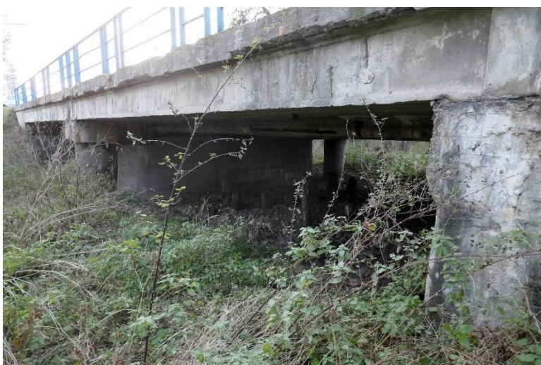
Pohled na most zprava.
