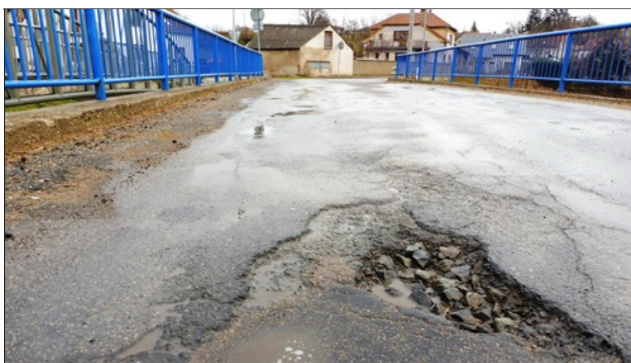
Poruchy a viditelná skladba vozovky na mostě
