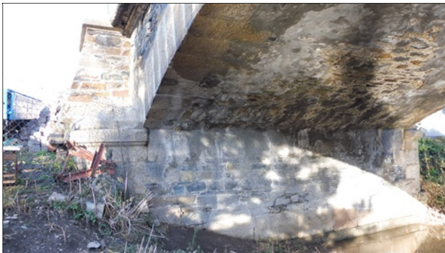
Podhled NK byl v minulosti sanován cementovou omítkou - lokálně.
