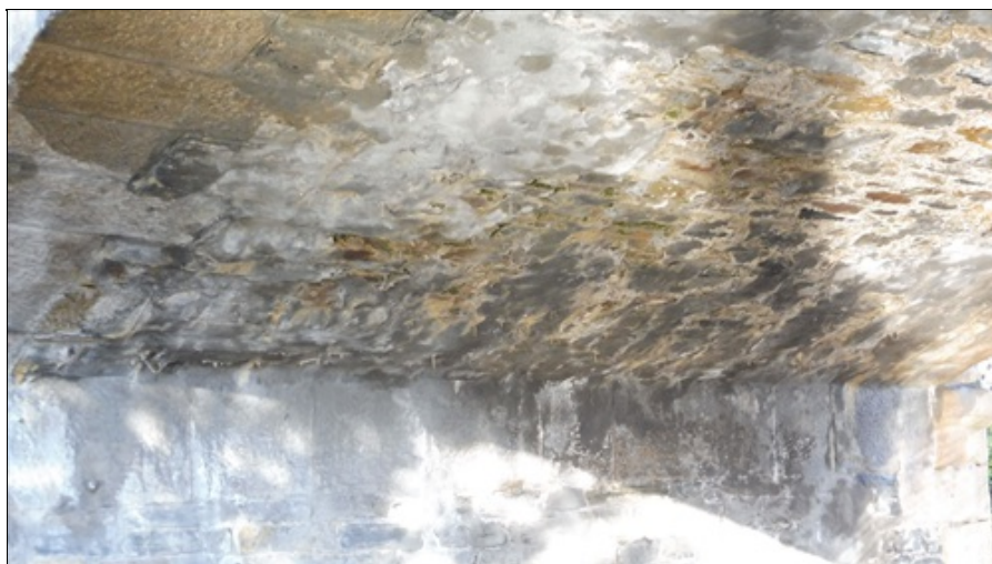
Detail sanace NK - stopy po protékání
