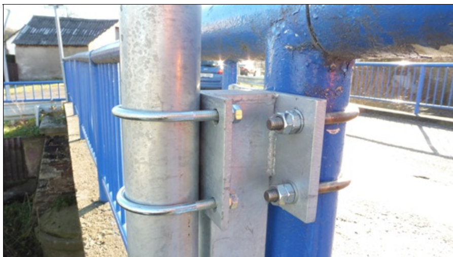
Ukotvení limnigrafu - detail
