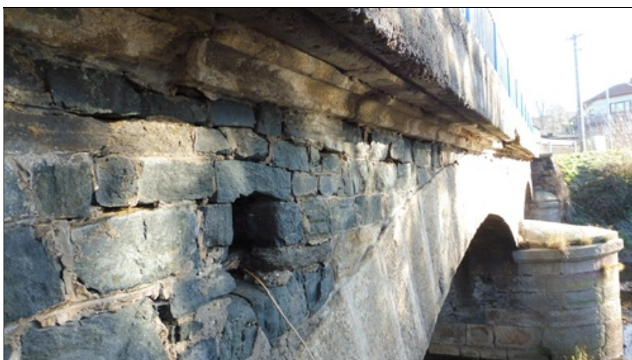
Detail zřejmě odvětrání v poprsní zdi nad prvním obloukem NK vpravo.
