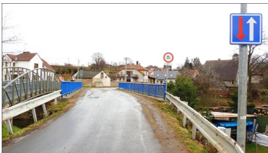
Vyznačení snížené zatížitelnosti dle poslední HPM
