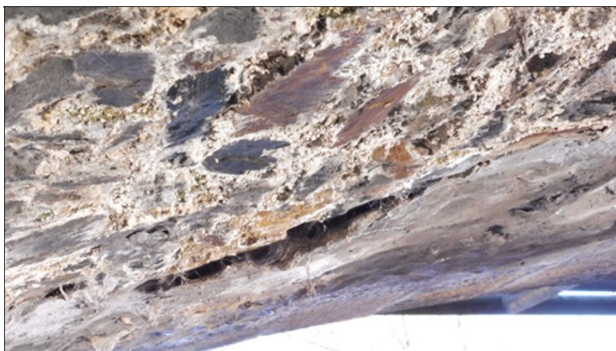
Detail stavu minulé sanace - odlupuje se.
