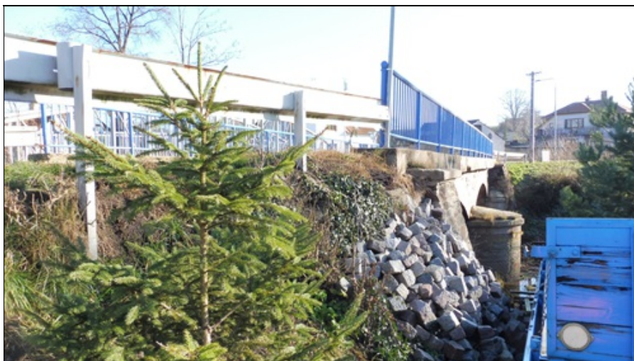
Provizorní přitížení pravého křídla u O1.
