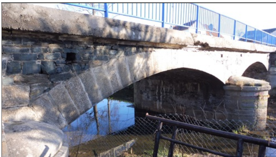
Pohled na most z prava - poruchy řimsy
