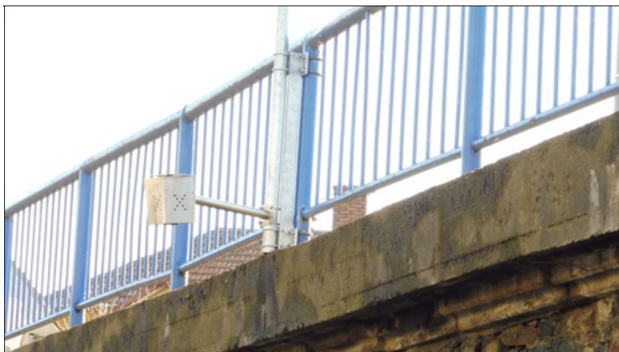
Instalace výstražného zařízení - hlášení stavu vodoteče.
