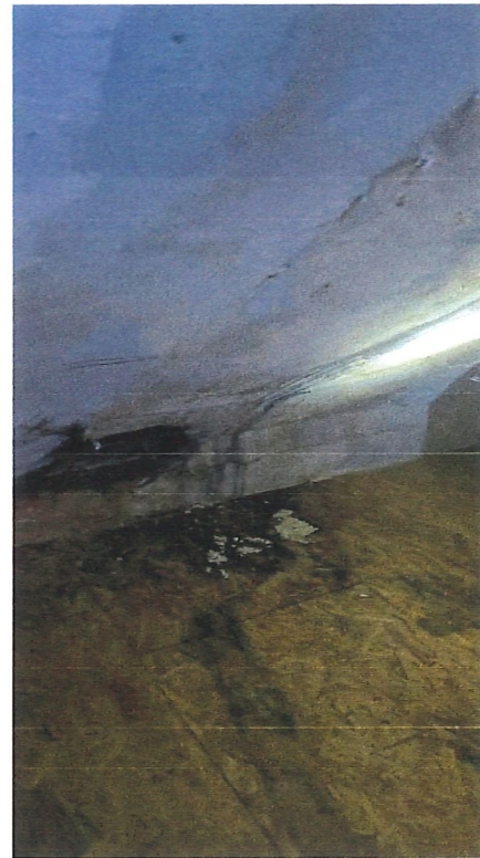
Pohled na vnitřní podlahu podkrovních prostor/půda.
