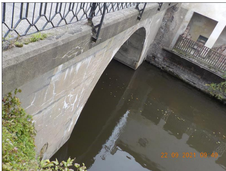
Levá strana mostu.
