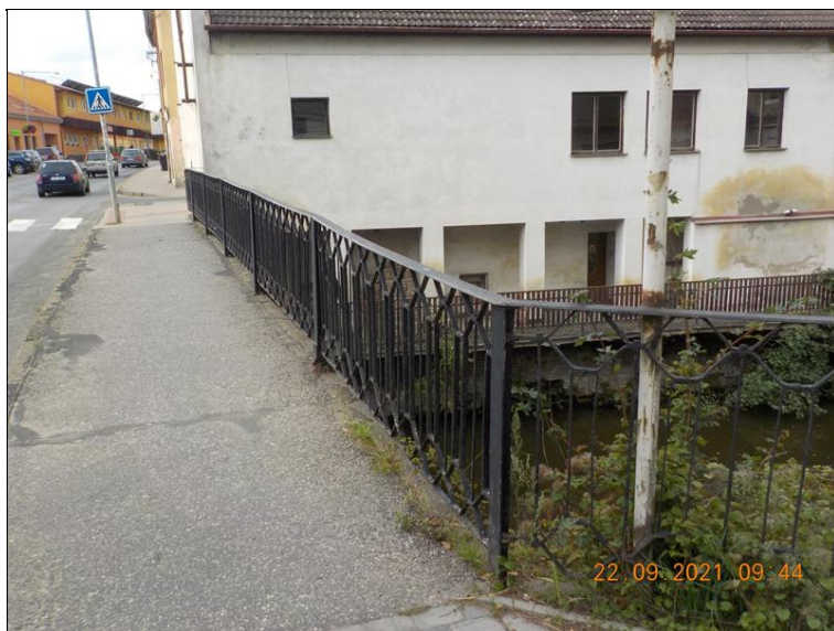
Levá strana mostu.
