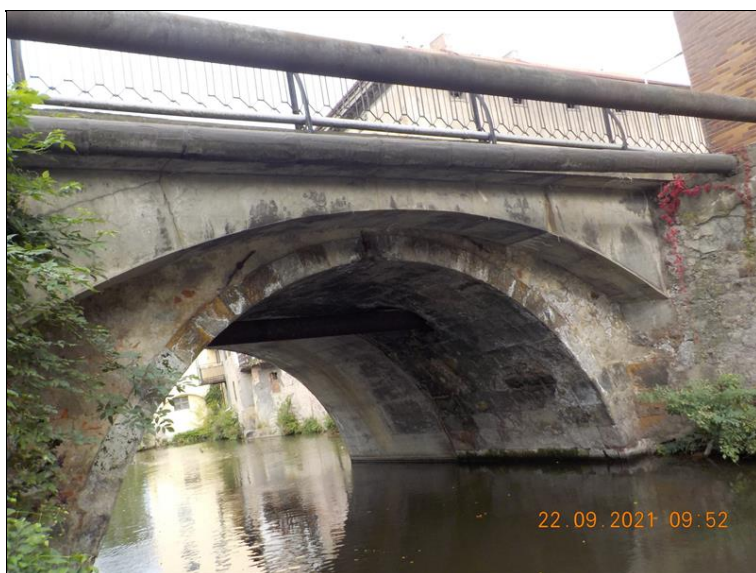
Pravá strana mostu.
