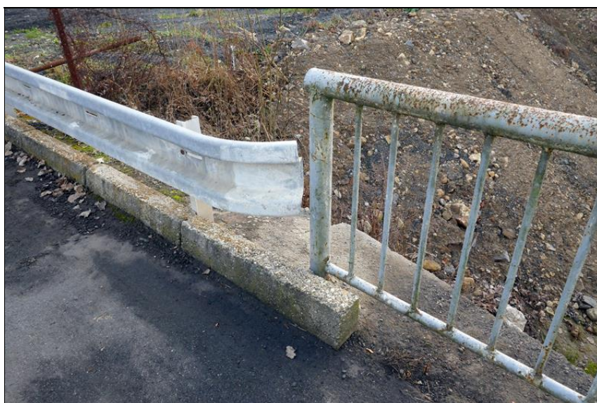
06_napojeni zabradli_svodidlo.jpg
