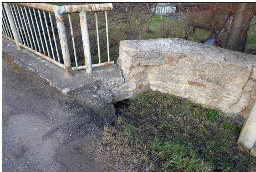
11_odvodneni na prave strane pred mostem.jpg
