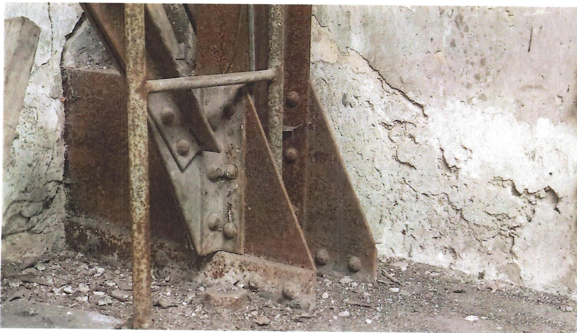
Obr. č. 11: Kotvení v místě B1 (JZ). Není patrné poškození viditelných částí. Žebřík přidán druhotně.
