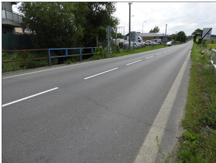
Příčná trhlina ve vozovce v místě nad OP3.
