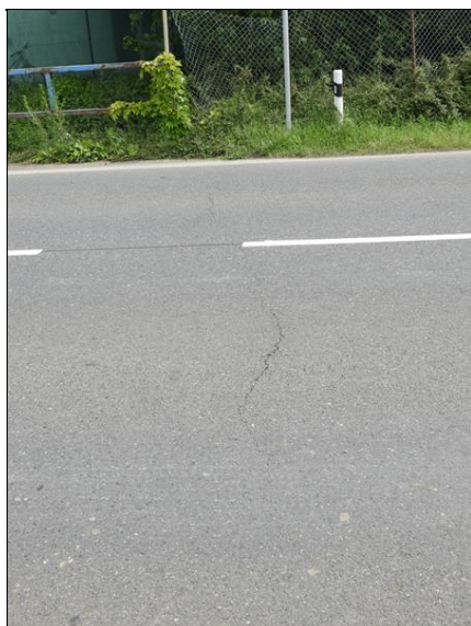
Příčná trhlina ve vozovce v místě nad OP3.
