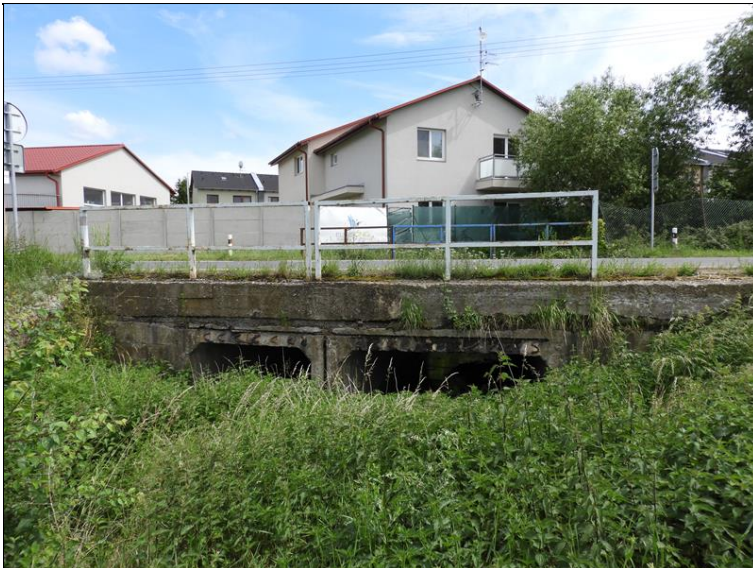
Pohled na most zprava.
